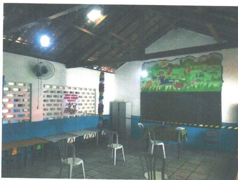
Imagem 4 – Sala de Aula
